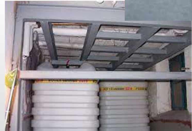
Variante 2 Tankanlage durch Verankerung sichern
